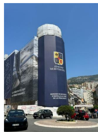
Scaffolding banner Place d'Armes
