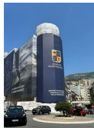
Bâche sur échafaudage chantier Place d'Armes
