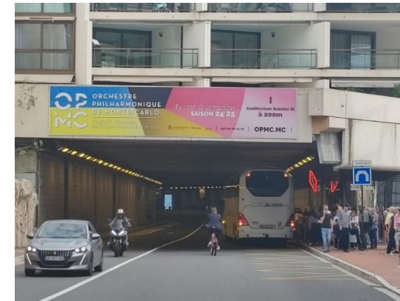
Bâche sur passerelle Tunnel Louis II
