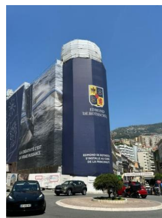
Bâche sur échafaudage chantier Place d'Armes
