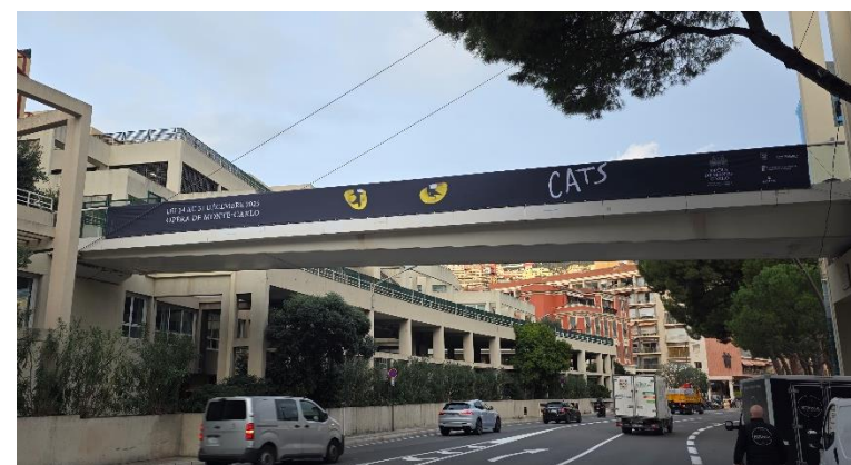
Bâche sur passerelle Quai Albert Ier
