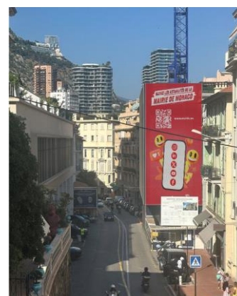
Exemple de projet ad-hoc (non réalisé) Echafaudage chantier Boulevard des Moulins - 1
